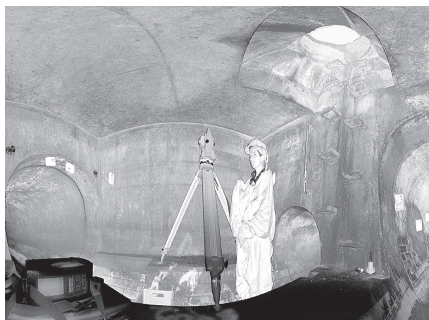
Rohdaten einer 3D-Vermessung im Kanal
