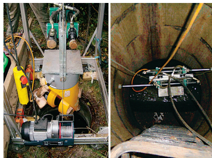
3D-Vermessung im Kanalschacht
